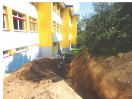
*Umfangreiche Grabungsarbeiten für die Nahwärme im Bereich der NÖ Mittelschule*
